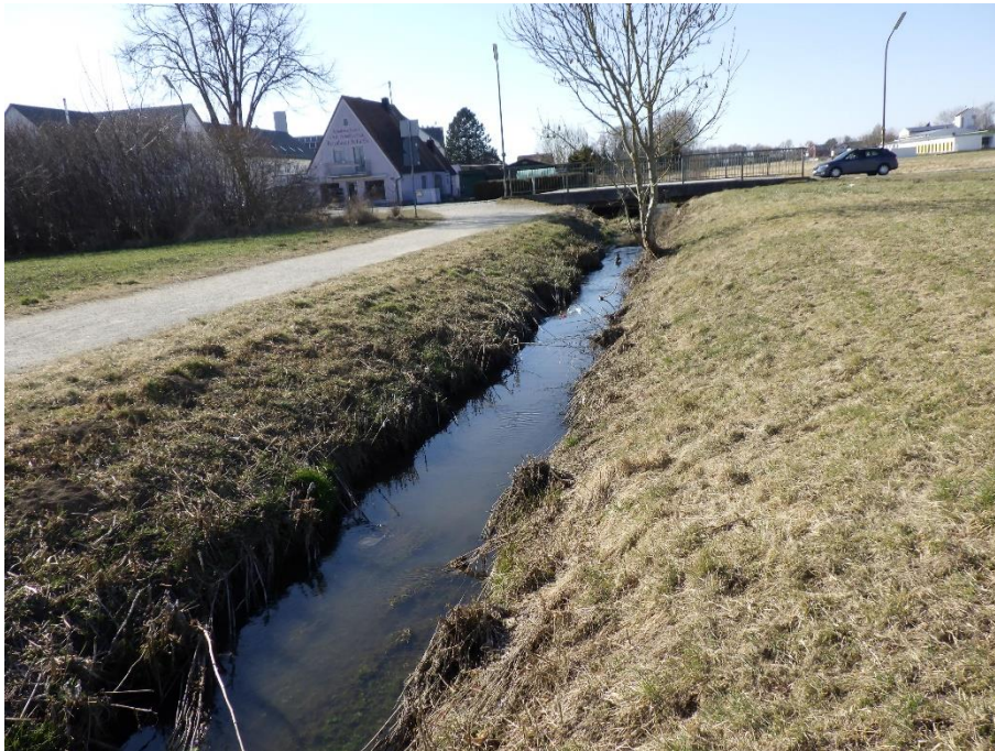
Abb. 4. Retzgraben mit Blick Richtung Westen mit angrenzender Grünlandfläche
