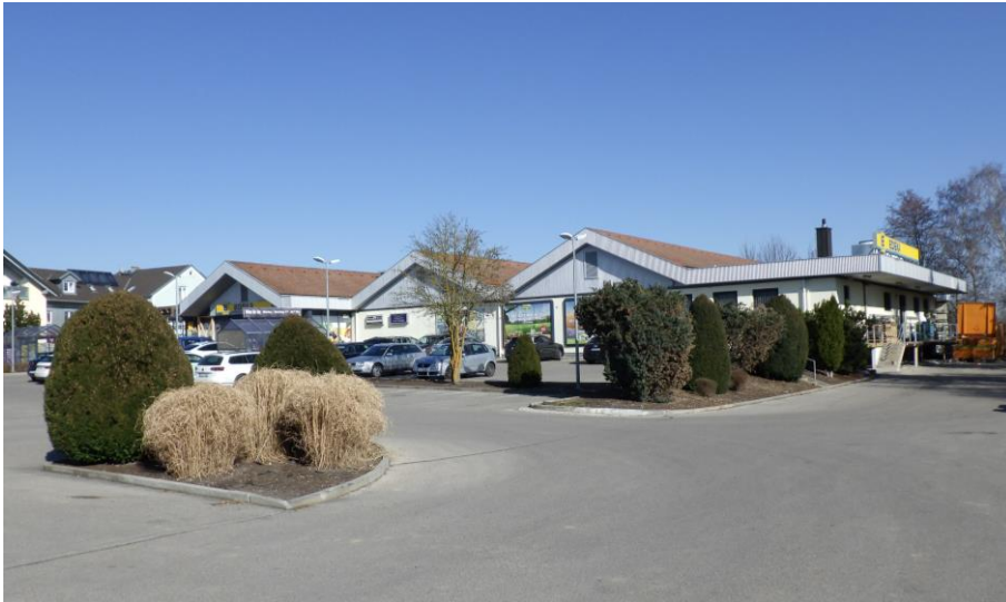
Abb. 6. Blick Richtung Nordosten, bestehendes EDEKA-Gebäude mit Parkplatz
